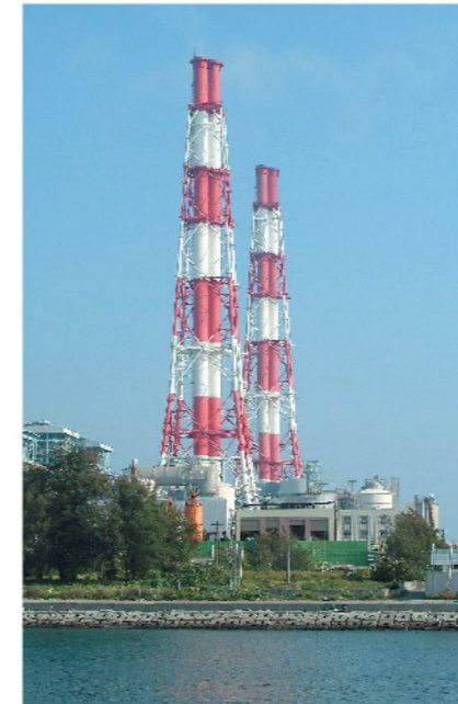
興達火力發電廠 Thermal Power Plant
